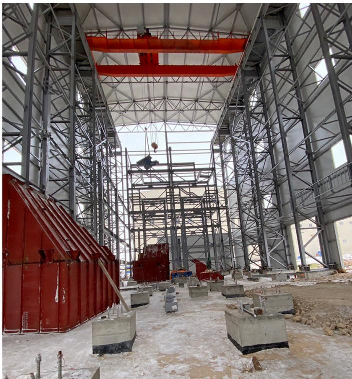
Кран мостовой опорный двухбалочный с электроприводом грузоподъемностью 35,0/5,0 тонн для предприятия в Республике Казахстан.
